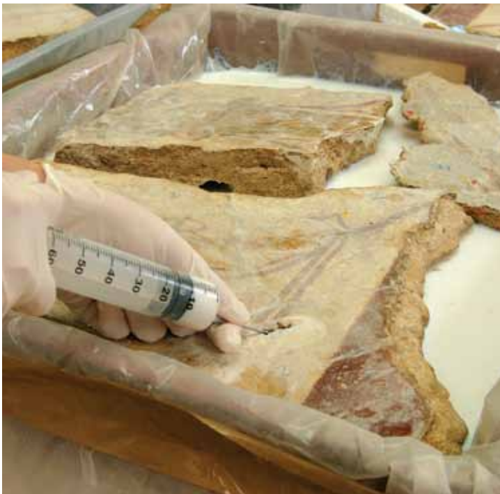
7. Consolidación del muro y la pintura in situ con resina acrílica en disolución acuosa. Muro del ambulacrum Oeste. Foto ALS
