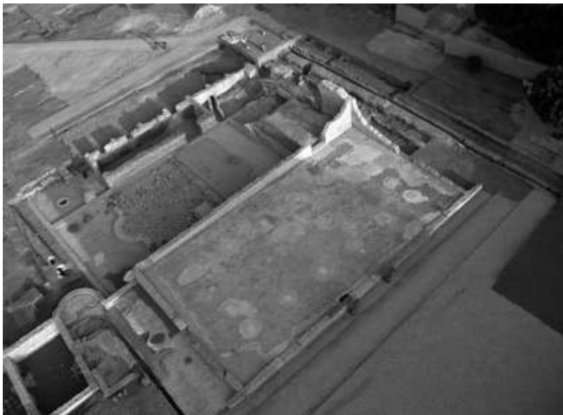
LÁM. VII: Vista aérea de los edificios desde el Sureste con el Paredón del Milagro, ya liberado del edículo que lo ha contenido hasta 2008 y en los últimos momentos de su restauración, que se está llevando a cabo en el momento de redactarse estas líneas.
